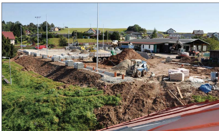
V září byla výstavba v plném proudu
