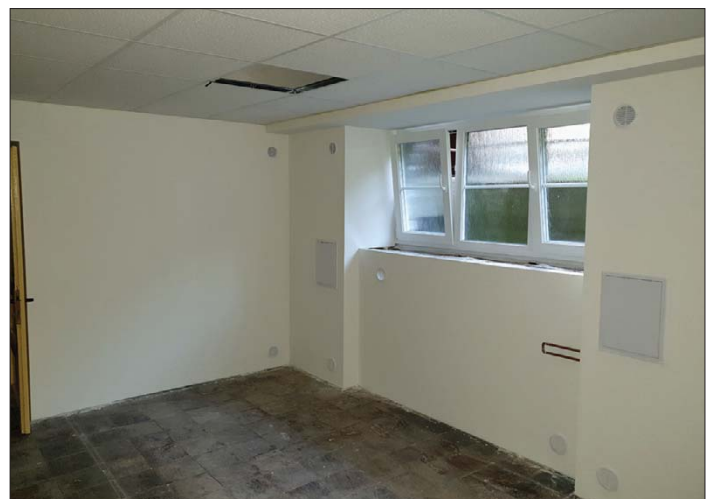
Šatna po rekonstrukci
